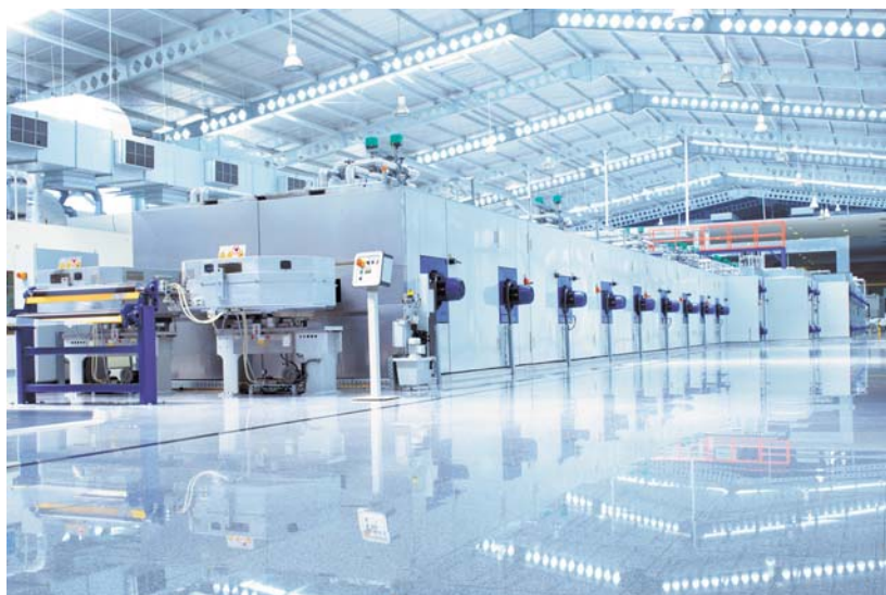
Die Streckanlage für acht Meter breite Folien ist insgesamt über 150 Meter lang; der Streckofen nimmt gut 80 Meter davon ein
